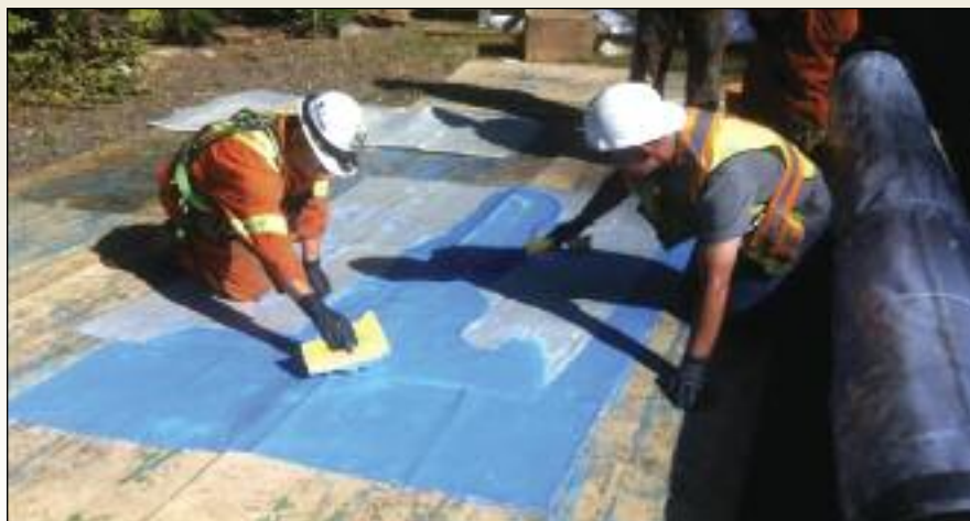
Drop structure liner wetout
